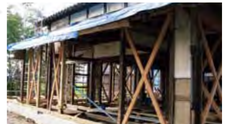
住宅の耐震改修工事
