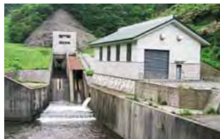
白中発電所(農業用水を利用した小水力発電)
