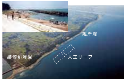
面的な海岸保全施設の整備(富山海岸)
