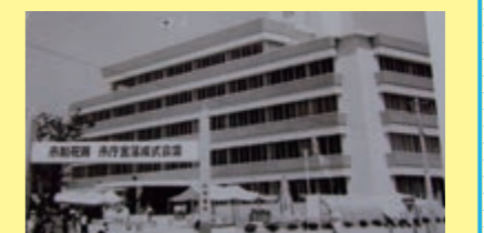
米太郎の寄付で小矢部市庁舎が建設されました。
