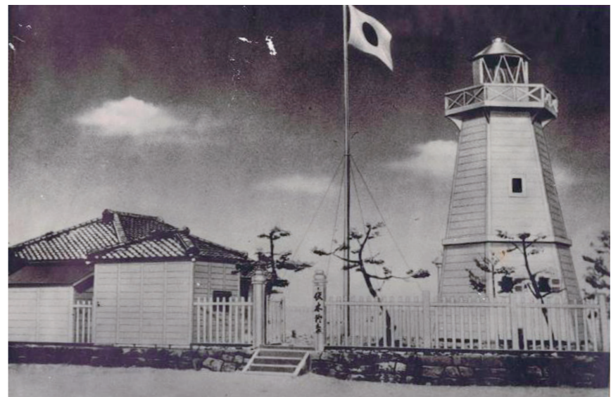
伏木灯明台は1877 (明治10) 年に建てられた日本海側初の西洋式灯台です。(高岡市立中央図書館蔵、高岡市立博物館提供)
