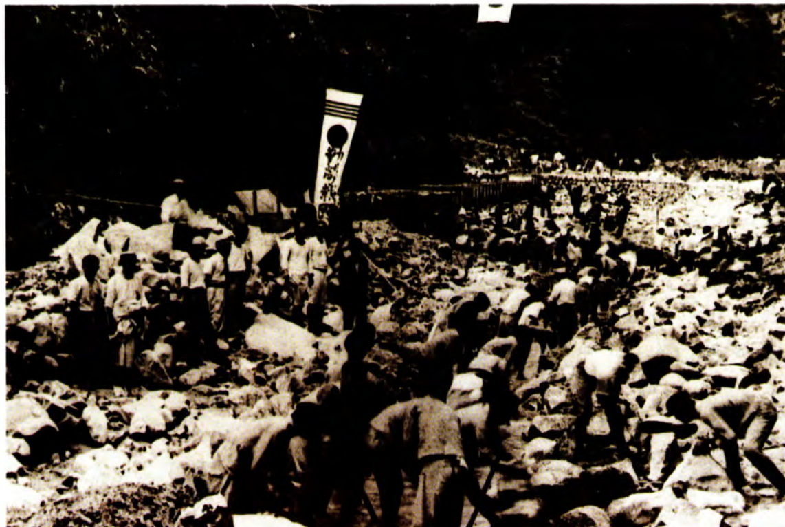
勤勞奉仕 上市農林学校(現 上市高校)生徒 による河川工事
