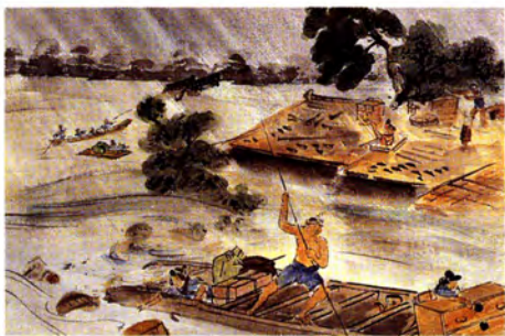
富山市の大水害 3年8月、豪雨が降り続き、神通川は13日夜半、有沢橋近くの堤防で欠壊。市内は泥海と化した。神通新大橋、桜橋などが流失し、浸水家屋6,850戸に達した。 (富山市50年史絵巻から)
