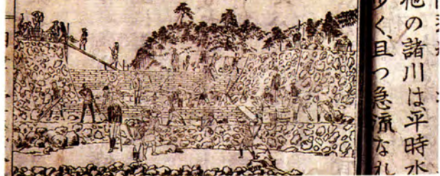
常願寺川大工工事
