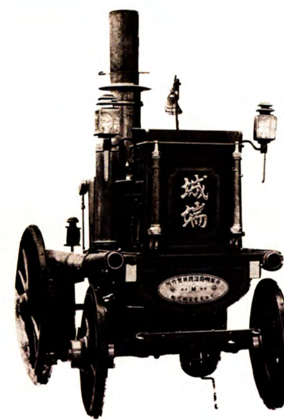
消防設備の近代化 40年に、城端町に火災があつて、10戸焼失。よつて蒸気ポンプ消防車を購入。当時、県内でも数少ない、新しい機械だった。
