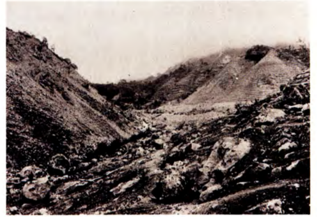
常願寺川砂防工事 24年、大出水のあと、ヨハネス・テ・レーケの設計により、河身の改修を行ったが、39年より、上流の湯川に砂防工事を進めた。
