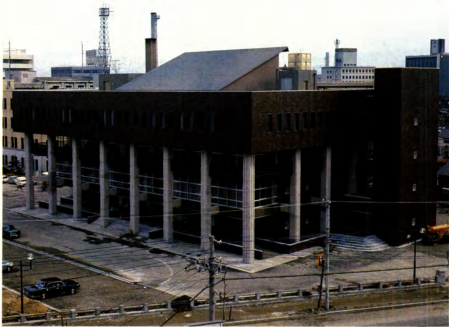
県議会議事堂 46年、県庁舎の西側に完成
