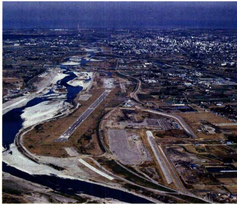
改修中の富山空港 ジェット機の就航のため改修
