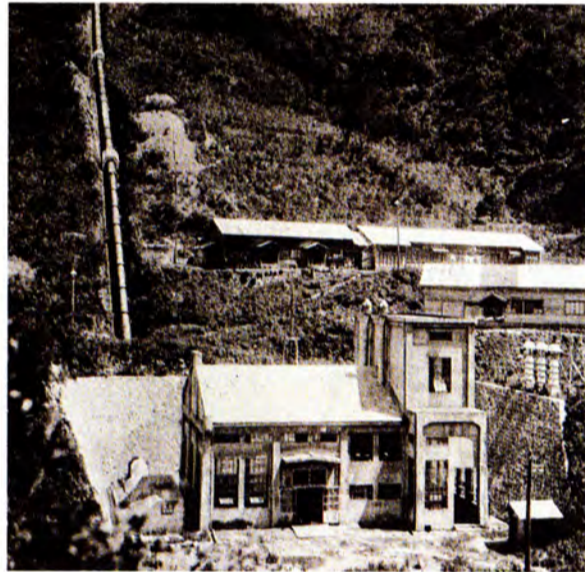
久婦須川発電所 14年、飛越電気が卯花村(現八尾町)に建設。出力3,600kW
