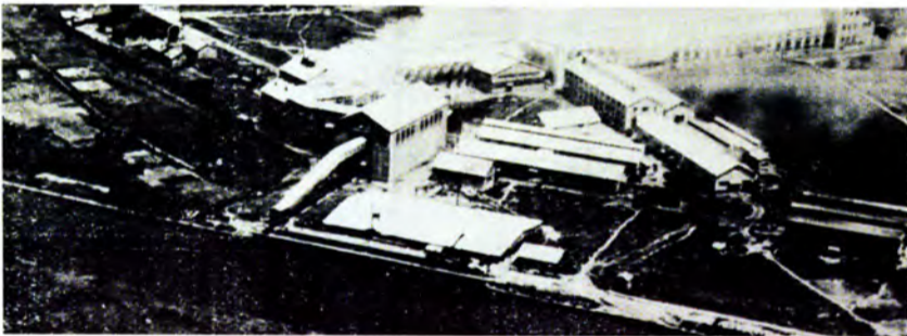
日満アルミ（現 昭和電工） 初期の富山北部工業地帯の中核になった。
