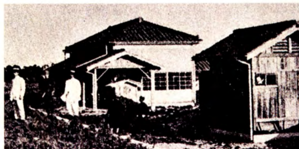
工事中の砺波鉄道(加越鉄道)津沢駅(現 小矢部市津沢)
