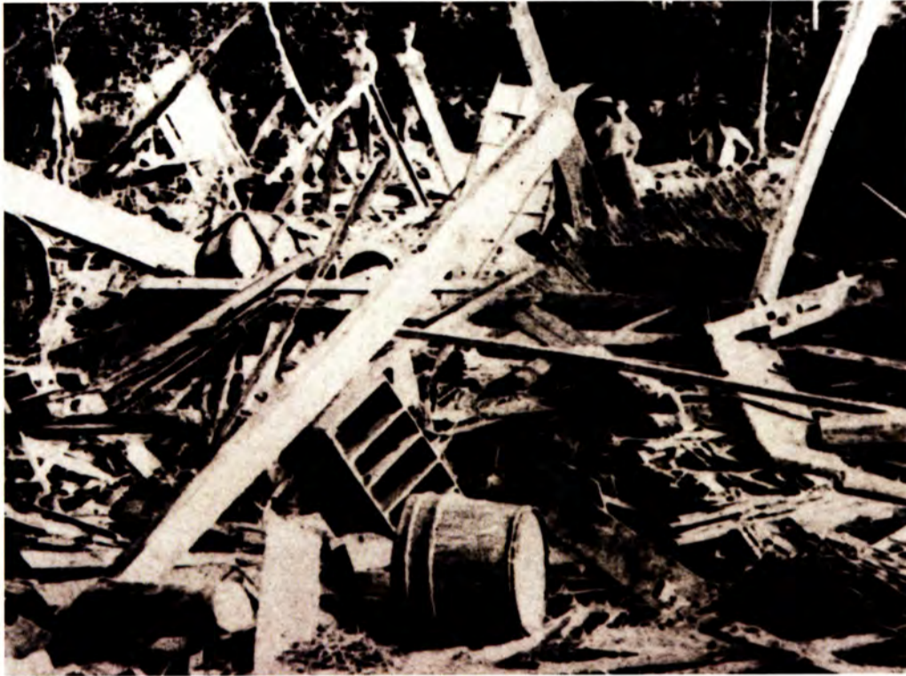
39年の庄川大洪水の惨状 7月中旬から連日降雨が続いたため、庄川が大出水。21日の午前、二塚村(現 高岡市)で堤防3カ所同時に欠壊。全河川の水が千保川に浸入して大被害をもたらした。
