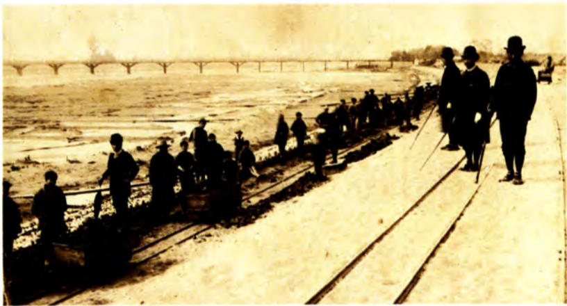
知事の工事現場視察 25年、森山茂知事の、常願寺川築堤工事、現場視察
