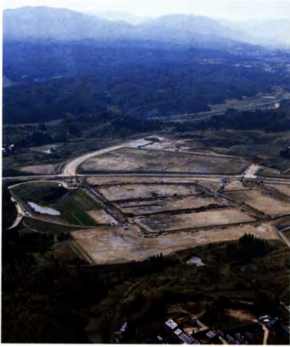
建設中の小杉流通センター 小杉インター周辺に建設がいそがれる トラックターミナル
