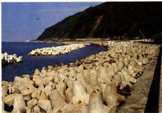
海岸線の保全 浸しよくから陸地を守るテトラポットの長い列。(朝日町)
