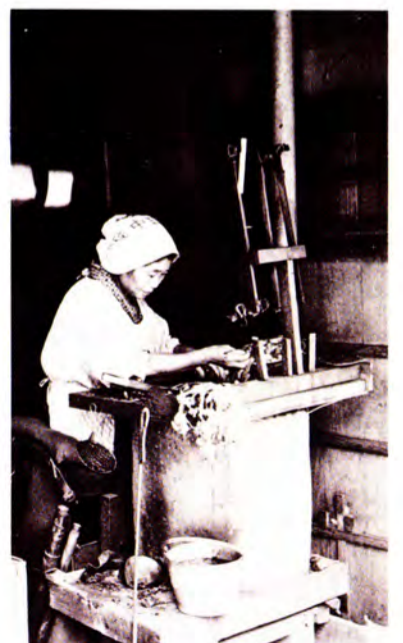
座繰り製糸 機械製糸以前は、座繰りて、釜の煮え湯の中に繭を漬けて、糸口を取り出し、糸枠に巻きとつた。
