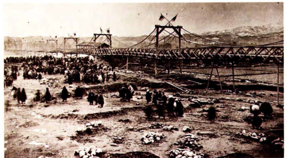
太田橋竣工祝賀式(現 砺波市) 33年に架設。当時は真取橋で、中央の小屋で番人が、大人1人、7厘の橋賃を徴収
