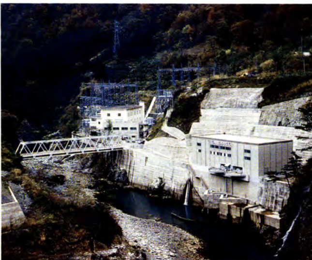
庄川筋の電源開発ブーム 成出発電所の建設。上平村
