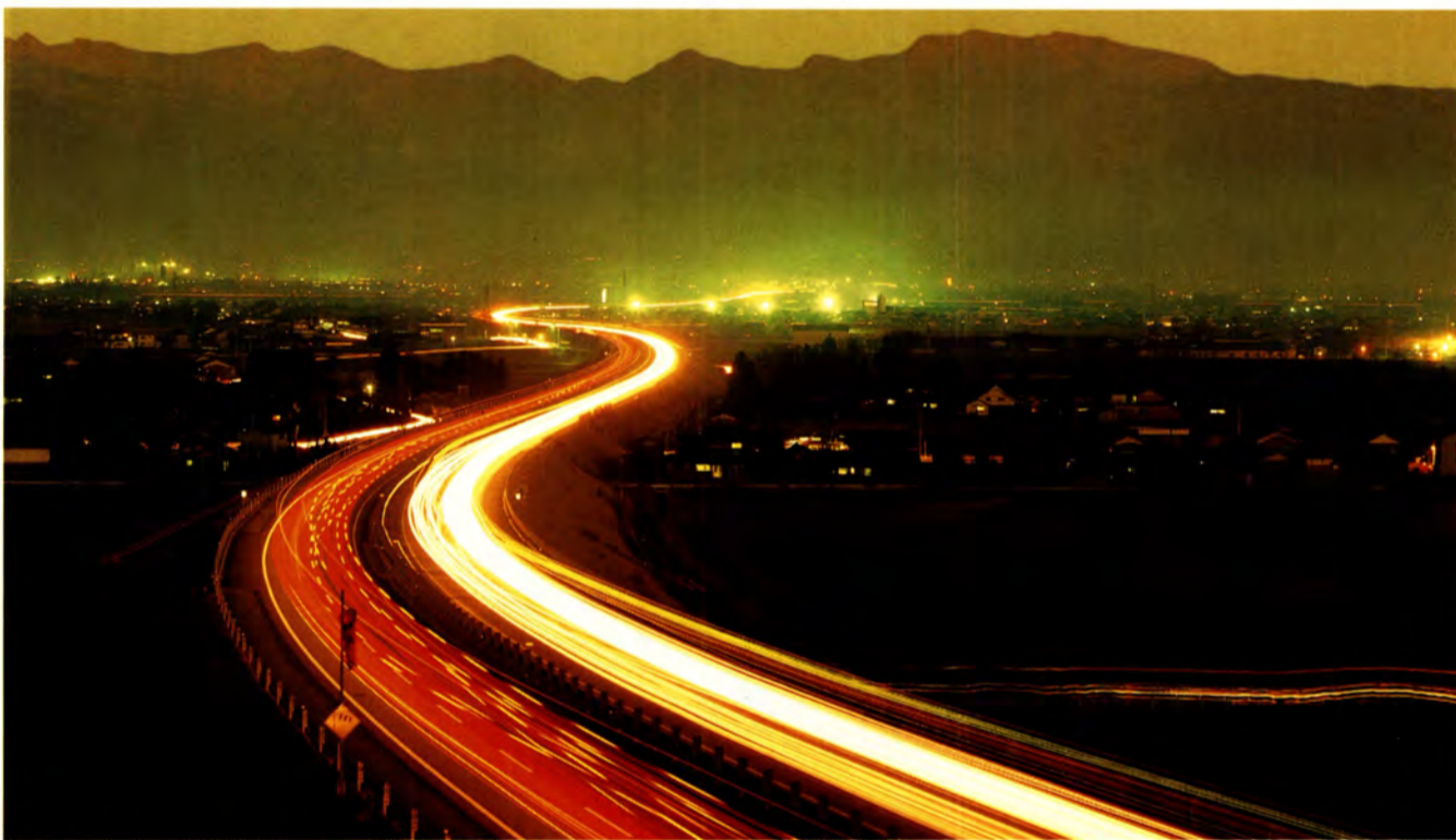
北陸自動道の夜景 富山インター付近（57年）
