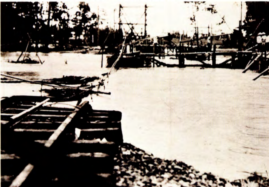
黒部川のはんらん 9年7月、左岸堤防の欠壊が特にひどく、生地(現黒部市)は孤立
