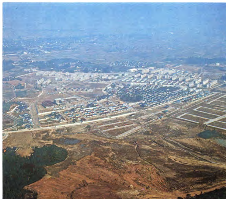
緑と太陽の町 太閤山団地の建設は続く
