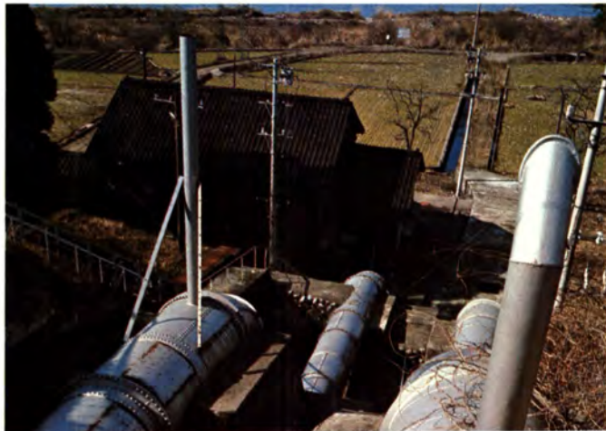
明治32年富山県ではじめてできた大久保発電所 大久保用水の水を利用して発電した（今の大沢野町塩）
