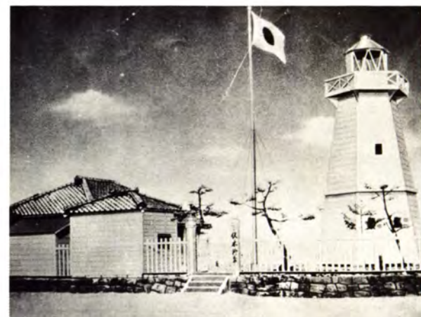
明治10年に完成した伏木燈台 富山県ではじめての洋式燈台である
