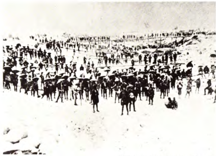
常願寺川改修工事(明治25年)
