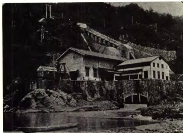
明治44年にできた庵谷第一発電所 これから工業用電力を供給できるようになる
