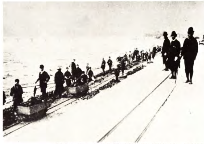
徳久知事の庄川改修工事視察(明治26~27年頃)
