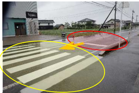
③対策後 移動された横断歩道
