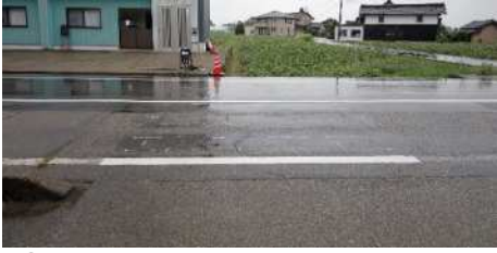
②対策後 撤去された横断歩道
