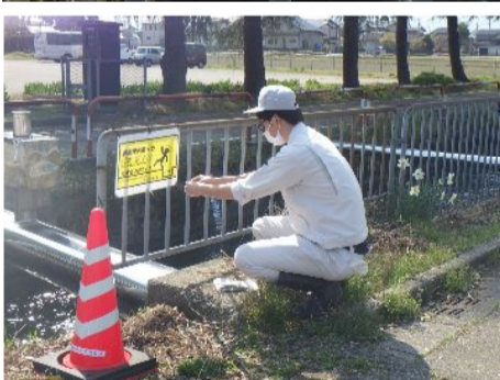
簡易看板の設置
