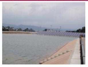
岸渡洪水調整池湛水試験(10/24~11/14)【砺波市高波地内】
