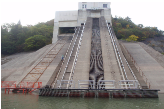
ダム湖面側から見た取水ゲート
