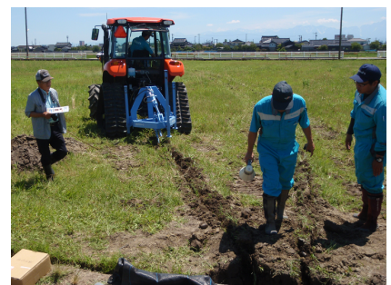
排水口から放射状に暗渠を施工
