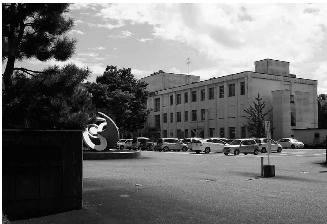
現庁舎 (S57.10～ 射水市中太閤山)
