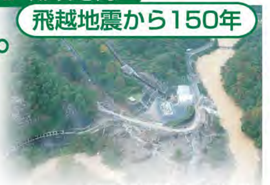
神通川水系茅谷川の土石流災害(H16.10)
