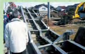
④2月24日に発生した富山湾沿岸の高波被害の状況が報告され、対策等が協議された。(写真は高波で破壊された防潮扉(入善町芦崎地区))
