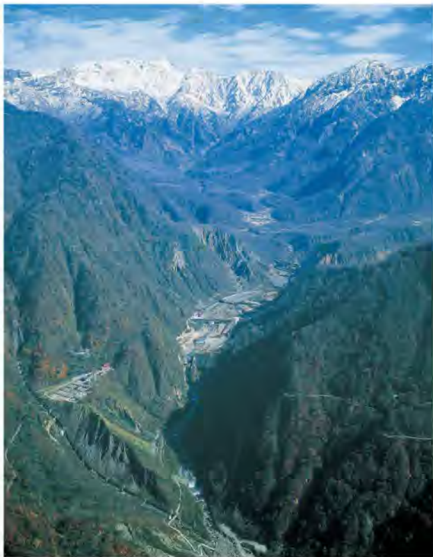
富山平野を守るため、今なお砂防工事が続けられている「立山カルデラ」。今も飛越地震により崩れた土砂が堆積している。(写真提供:国土交通省立山砂防事務所)
