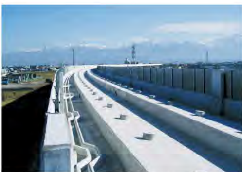
建設が進む北陸新幹線(富山市小西高架橋)
