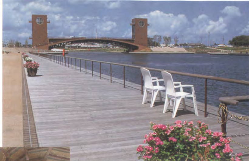
運河の両岸には木製デッキが設けられている。向こうに見えるのが天門橋。展望塔の垂直のイメージを表す「天」と、形が表す「門」を組み合わせその名がつけられた。
