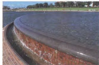
泉と滝の広場にある水盤。中心から毎分8m 3 の水が湧き出ている。
