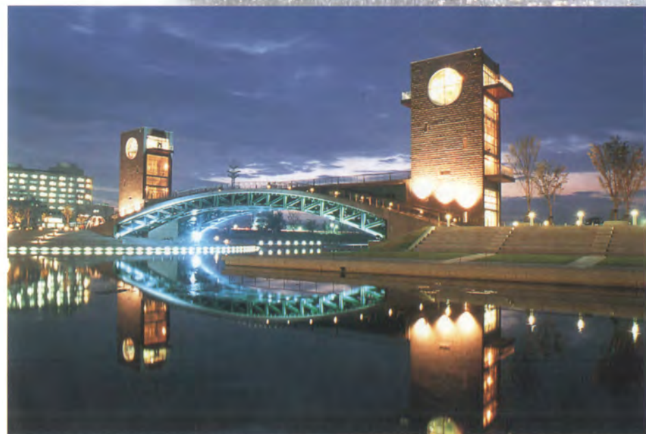
ライトアップされた天門橋。幻想的でロマンチックな夜景が、訪れる人の心をときめかせる。美しいアーチと展望塔、そして周囲の建物が水面に映り、新しいお水空間をつくっている。
