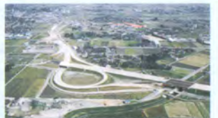
工事が進む能越自動車道高岡インターチェンジ
