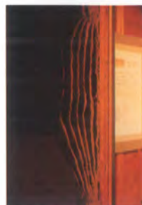
土蔵の壁は7層に塗られ、厚さは25cm以上。展示室では断面も見ることができる。
