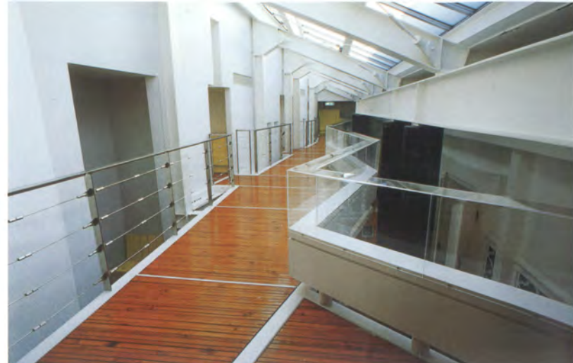
2階の吹き抜けは、ガラス、金属、木という異素材が融合した明るい光の空間。ガラスの手すりのラインは、善徳寺山門に彫刻された龍をイメージしている。
