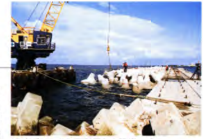
消波ブロックを再利用した護岸工事
