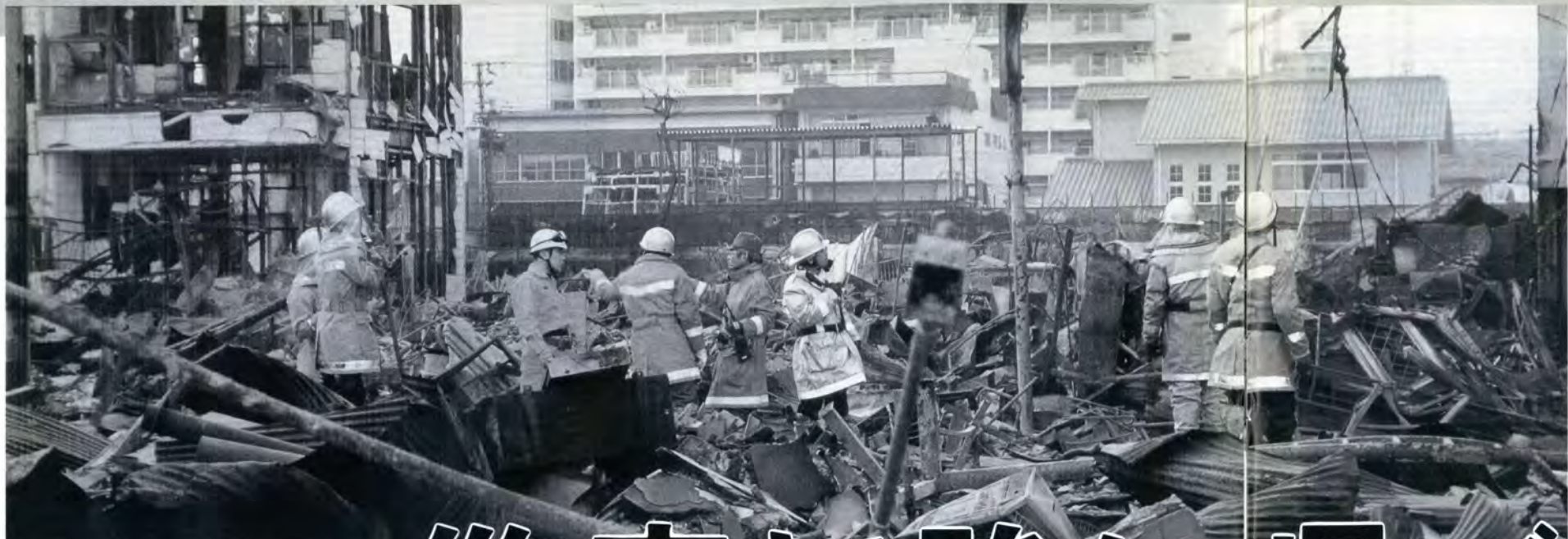
▲神戸市長田区御蔵通りの建物倒壊・火災現場
