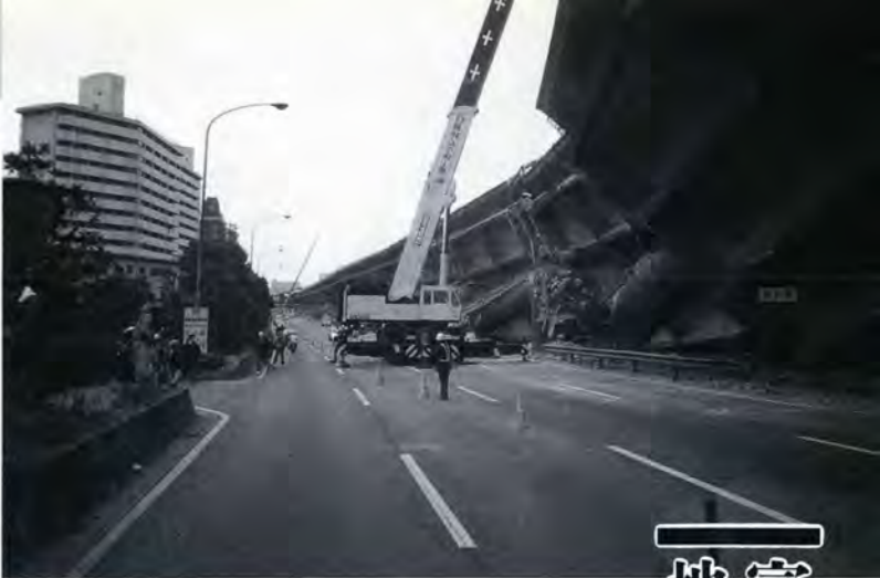
横倒しになった高速道路▶ (長田区)
