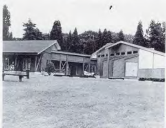
▲頼成の森「森林科学館」竣工 8/3
