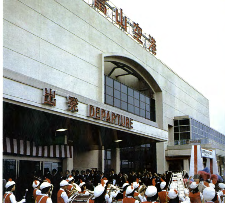
新空港にふさわしく、充実した機能をもつ空港ターミナルビル
