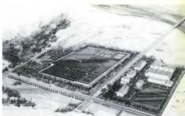
小矢部川流域下水道の幹線管渠の埋設や浄化センターを建設
