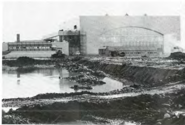
建設すすむ総合体育センター大体育館
