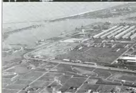
◀富山新港工業地帯の西側に造成されていた県民公園新港の森も完成
