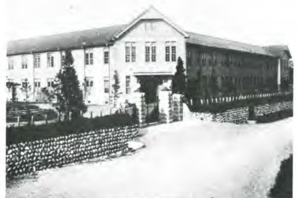
官立高岡高等商業学校の校舎(高岡市中川園町)
