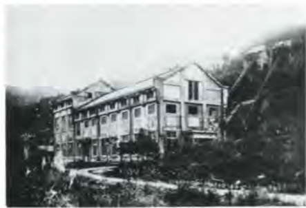
松ノ木発電所
