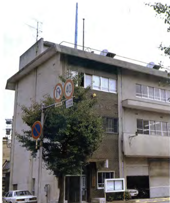
▲ 交通管制センター
