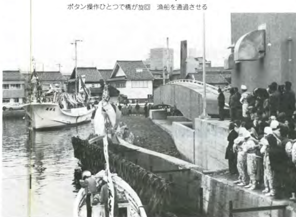
ボタン操作ひとつで橋が旋回 漁船を通過させる
