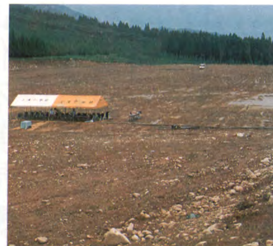
リレースタートゾーン整地終る
