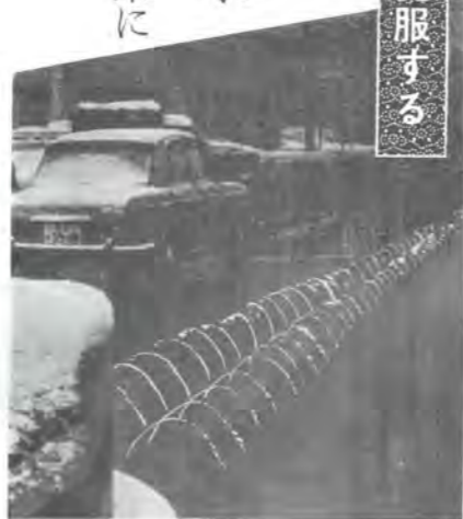
地下水利用の融雪装置(県民会館前)
