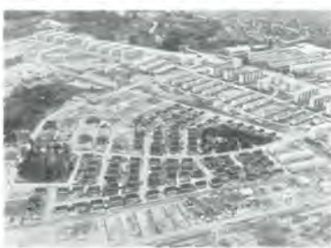
きれいに整備された太閤山地区
