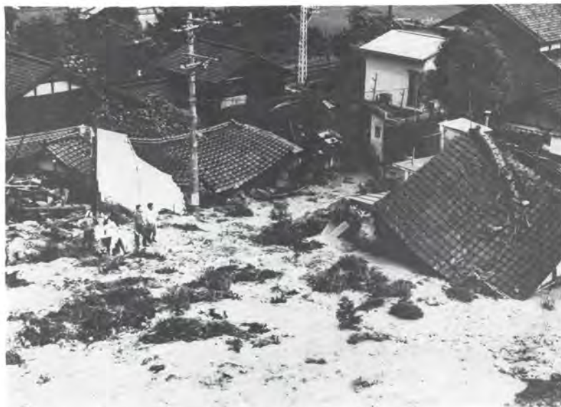
44年8月豪雨の地すべりで倒壊した民家(大山町地内)
