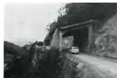
利賀村に設置されているスノーシエッド
