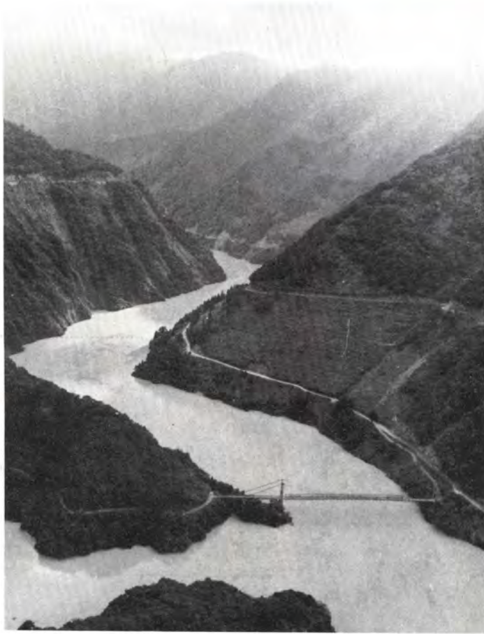
庄川と利賀川の合流点、つり橋は利賀大橋
