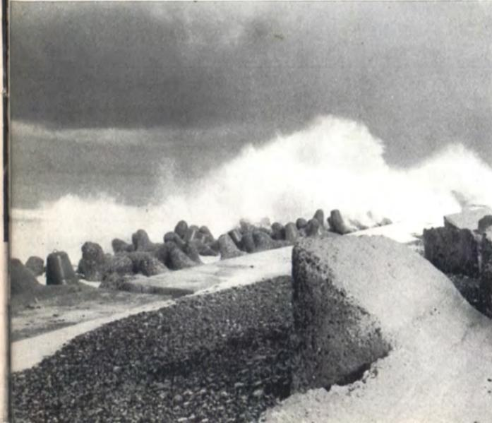
10メートルを超える高波にさすがの防波堤も倒壊(昭和38年1月)
