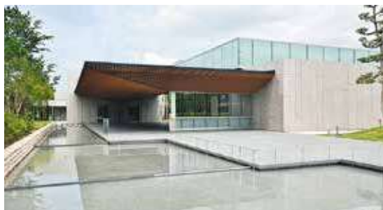
高志の国文学館 (全建賞、中部建築賞、JIA優秀建築賞を受賞)
