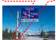
既設道路標識柱への 海拔等の表示
