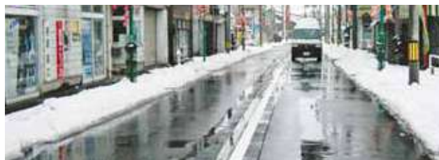
消雪施設の整備
