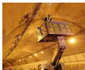
トンネル点検
