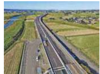
4車線化完成区間 (南砺スマートIC～小矢部砺波JCT) 写真提供：中日本高速道路(株) 富山高速道路事務所
