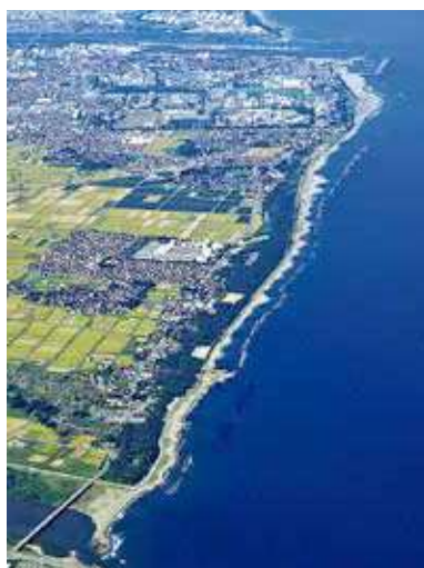
海岸侵食対策事業を進めている富山海岸（富山市）
