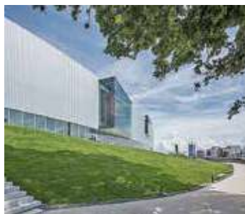
アルミスパンドレルによる外壁 (富山県美術館)
