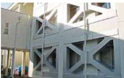
耐震改修（衛生研究所）
