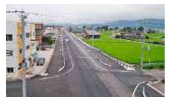
県道 砺波福光線 【南砺市吉江中～遊部】
