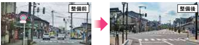
電線共同溝整備による無電柱化【国道415号(氷見市中央町地内)】
