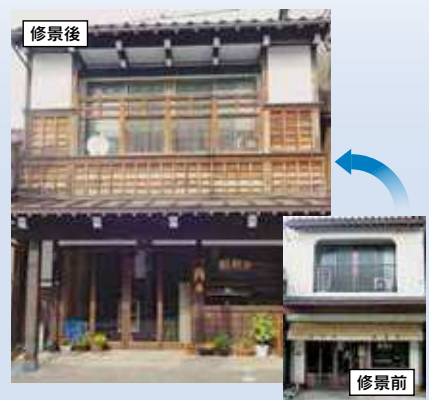
「いなみ上新町歩いて楽しめる町づくり協定」に基づく修景（南砺市）
