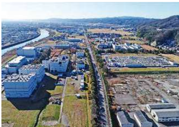
小矢部川流域下水道 二上浄化センター (高岡市二上地内)
