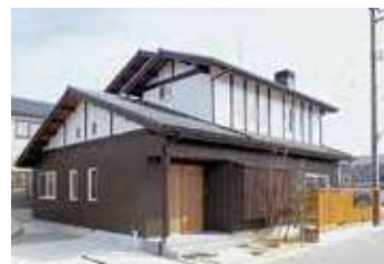
耐久性等に優れた長期優良住宅
