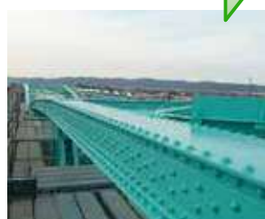
鋼橋の防食機能維持
