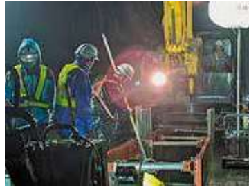
生活インフラを支える夜間工事
