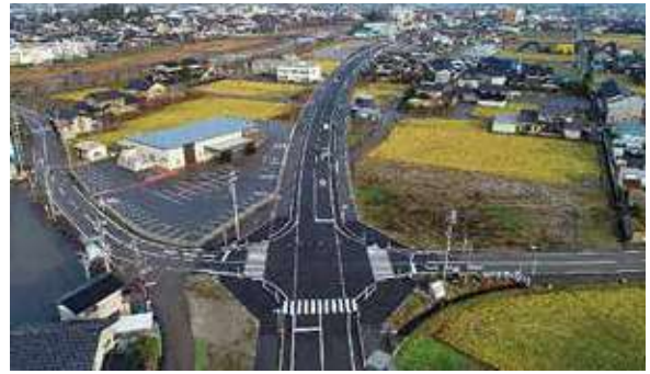
国道304号荒木高宮バイパス
