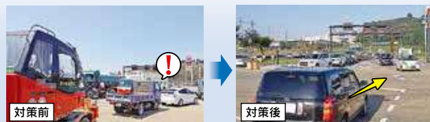
右折レーンの2車線化により、右折車の見通しを改善
