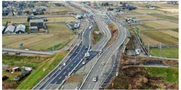
整備を進めている高岡環状道路【高岡市上伏間江～佐野】
