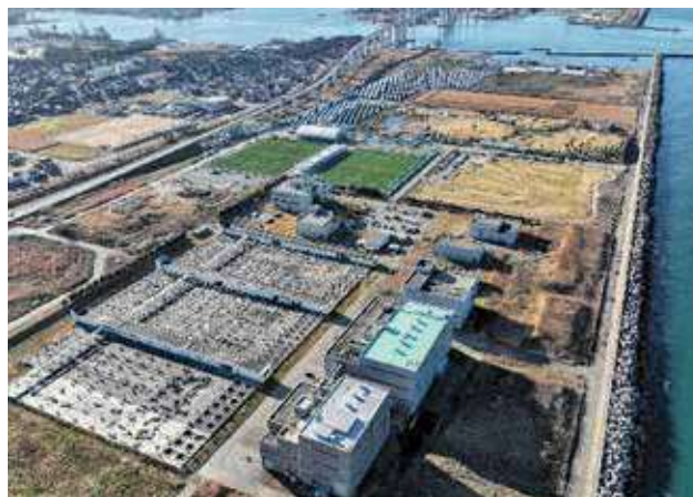
神通川左岸流域下水道 神通川左岸浄化センター (射水市海竜町地内)
