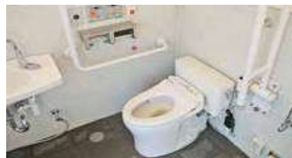
多目的トイレ（海王丸パーク）
