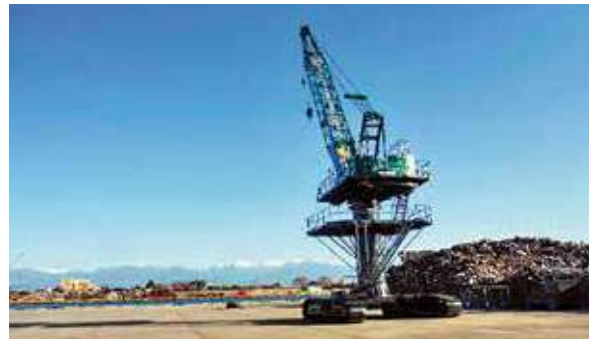
伏木富山港(富山地区)80t吊ハイポストクレーン
