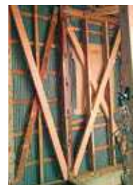
木造住宅の耐震改修工事
