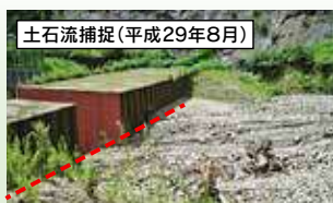
土石流捕捉(平成29年8月) 除石実施(平成30年6月)
