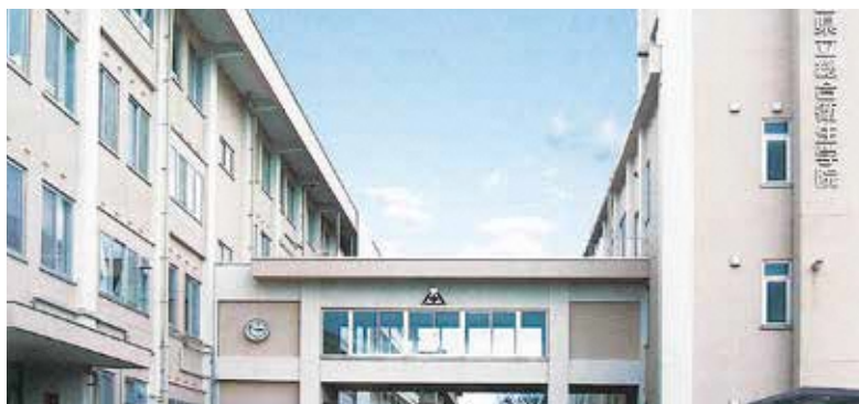
平成21年 校舎改修工事竣工
