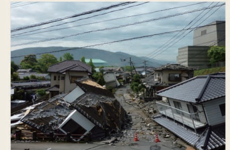
<住家被害の様子：熊本地震>
