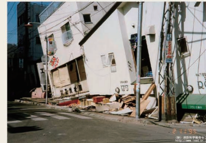
<住家被害の様子：兵庫県南部地震>
