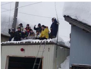
屯所の屋根雪下ろし、完了！
