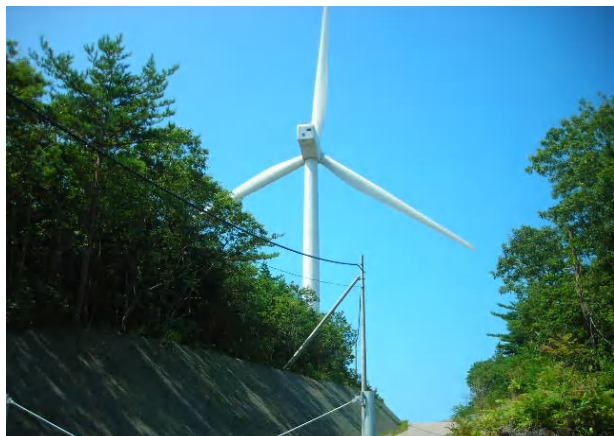
福浦風力発電所の風車 全高70mのタワーの上で、ロータ径96mの羽根が回っており、近くから見上げると、壮観であった。
