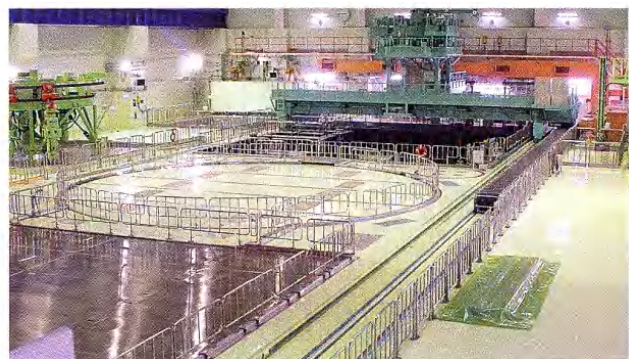
志賀原発2号機 原子炉建屋内(写真提供:北陸電力株式会社) 中央の丸い部分のコンクリートを動かすと、原子炉圧力容器が見られる。定期検査はほぼ終了しており、二酸化炭素排出削減のためには、安全対策を確認した上での早期稼働が望まれる。
