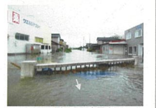
地久子川(高岡市) (平成24年7月豪雨による浸水状況)
