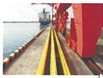
新湊地区:ガントリークレーンのレール延伸整備
