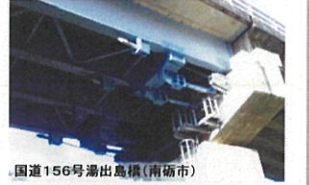
国道156号濁出島橋(南砺市) 橋梁の耐震化(落橋防止装置設置状況)
