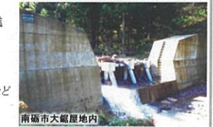
南砺市大蔵屋敷内 流木対策の実施(流木を捕捉した治山ダム)
