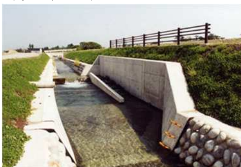
魚の遡上に配慮した整備 (庄助川 入善町)
