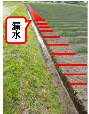
写真1 額縁排水溝と植え溝 ※赤線部分とはつながない
