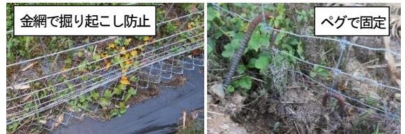
地際を掘られて侵入される場合は、柵下部を補強資材で強化
