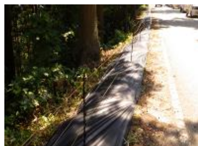
電気柵下へ通電性シート設置
