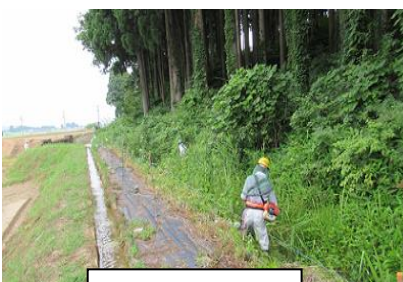
緩衝帯の設置
