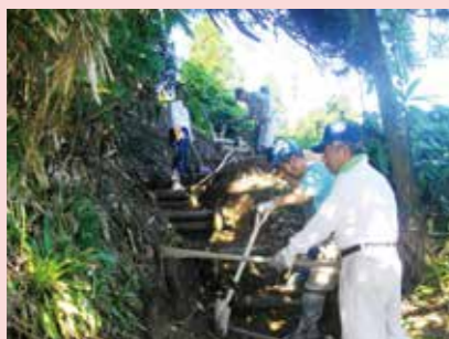
遊歩道の整備
