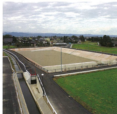
全国的にも稀な浸透型洪水調整池 (砺波市神島地内)
