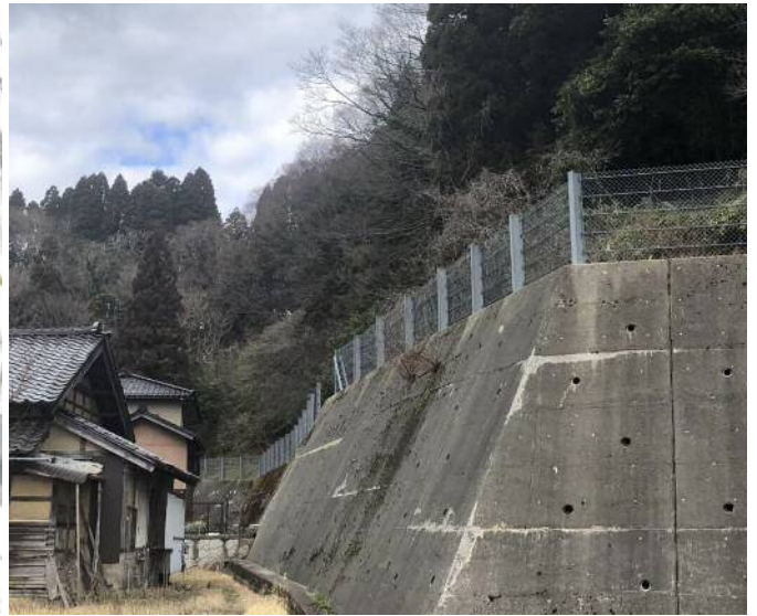
氷見市 脇方地区 待受式コンクリート擁壁工(もたれ式)
