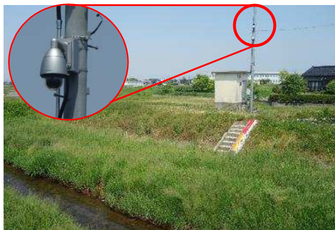
河川監視カメラ設置状況
