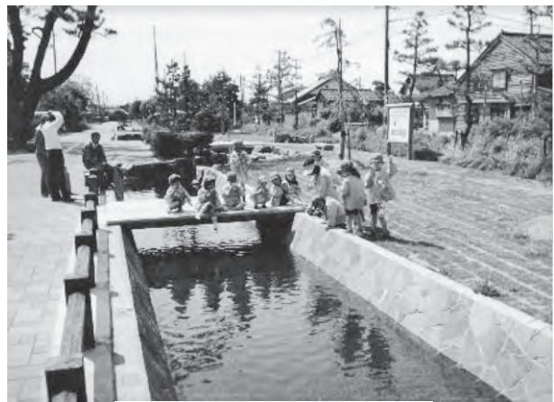
射水市 堀岡雨水幹線
