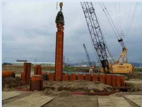
鋼管矢板の例(打設中)
