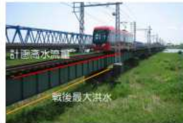
図3-17 万葉線橋梁と計画高水流量・戦後最大洪水時水位の関係
