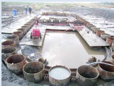
鋼管矢板の例(打設完了)
