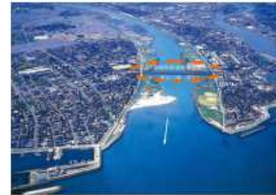
図5-7 橋梁架替箇所状況
