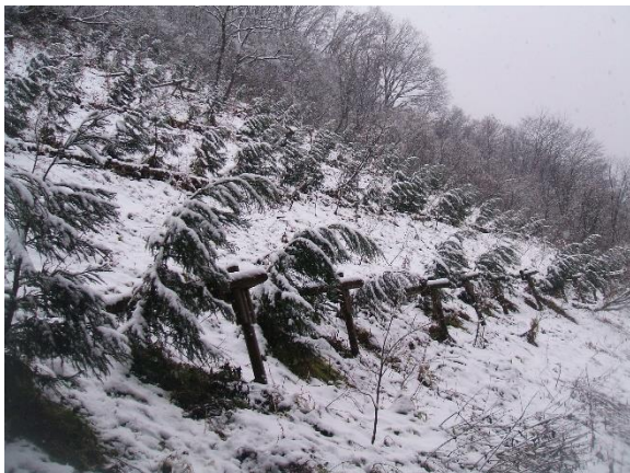
施工後3年の様子
