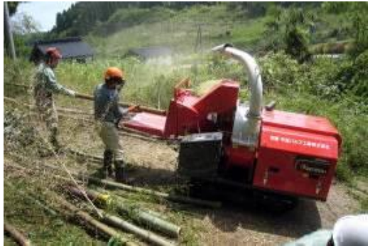
伐採木竹を処理するチップパー機の貸出し
