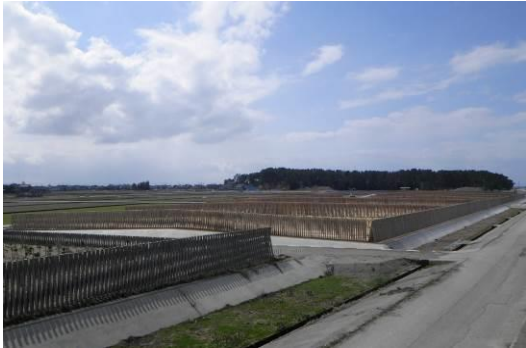
海岸保全対策の推進（入善海岸）
