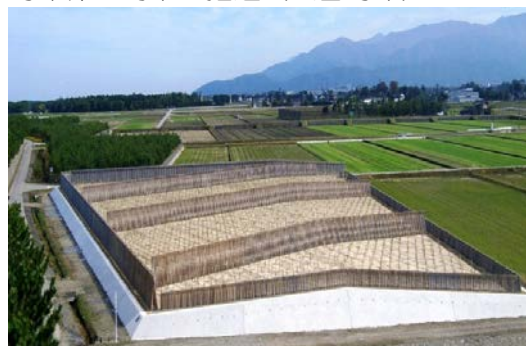
海岸保全対策の推進（入善海岸）
