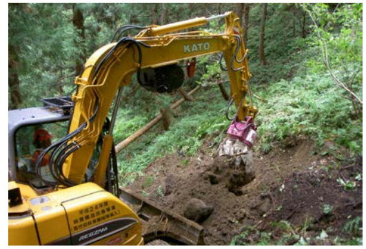
最新の林業機械による作業道作設状況
