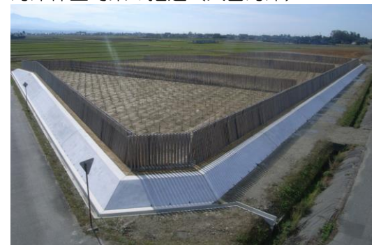
海岸保全対策の推進（入善海岸）
