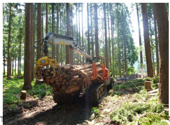
施業集約化地区における間伐材搬出状況
